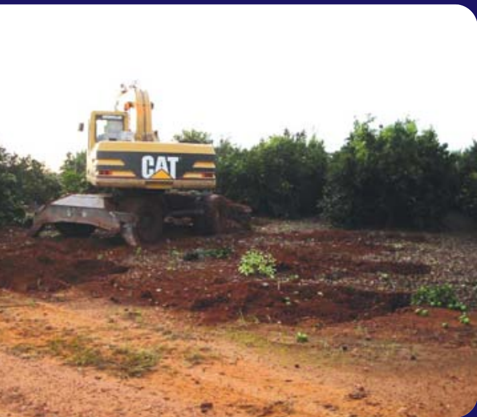
Obres de l'AVE al terme de Torrent.
