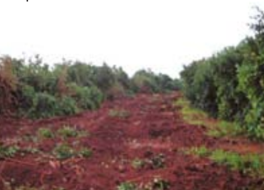
Obres de l'AVE a l'Horta Sud.
