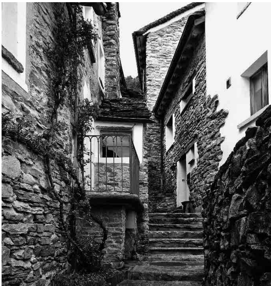
5 La muratura a vista dominante
